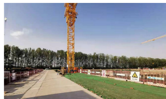
裸露边坡防尘网覆盖
